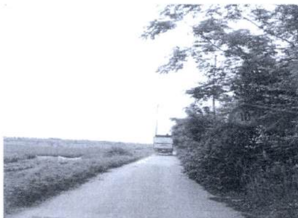
Đường bê tông
